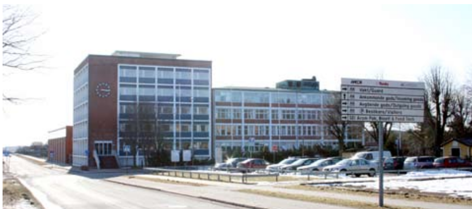
Kontorbygget på Lyckebacken 5 i Lund som nå rehabiliteres.
