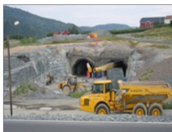
Tunnelinnslag ny E16 Wøien – Bjørum
