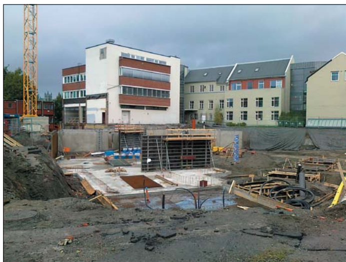
September 2009. Riving og grunnarbeider er ferdig. Byggets kjeller er under oppføring.
