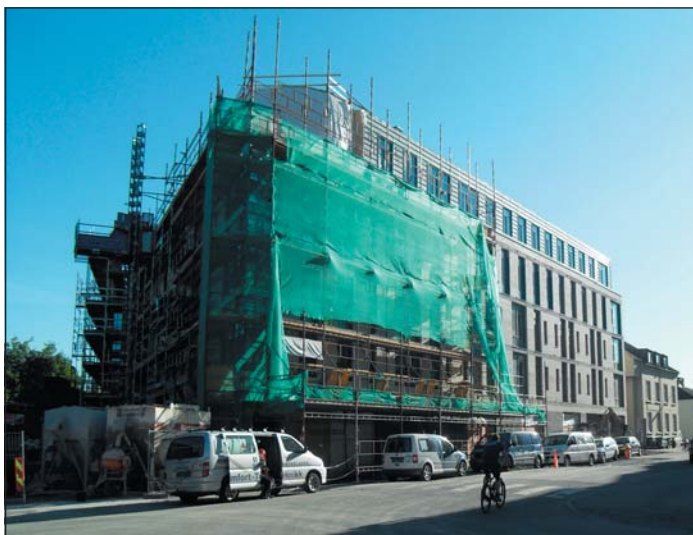
August 2010. Fasadene nærmer seg ferdigstillelse, samtidig som innregningsarbeidet pågår for fullt.
